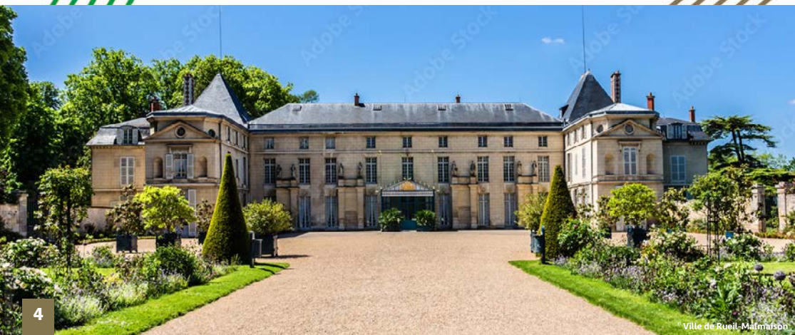
© Ville de Rueil-Malmaison
